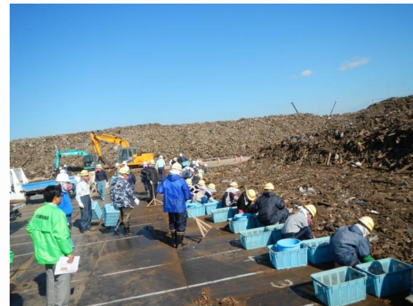
←細かいがれきを手作業で14品目に分類し、98%を再利用する。被災者から希望を募ることで被災地における雇用の一助になっている。
