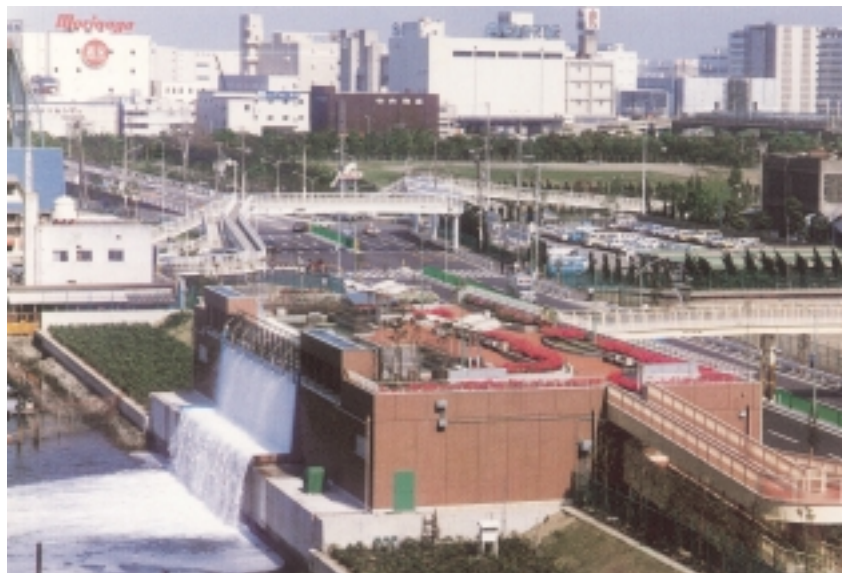
平和島運河埋立工事
