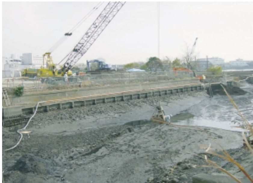
施工中のふるさとの浜辺
