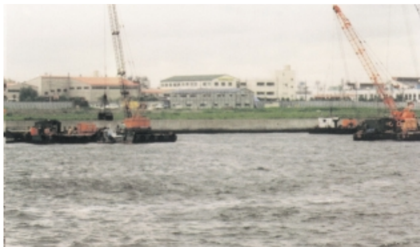
京浜島護岸建設工事
