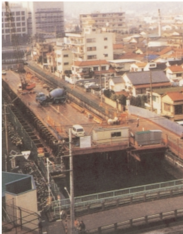
呑川防潮堤工事
