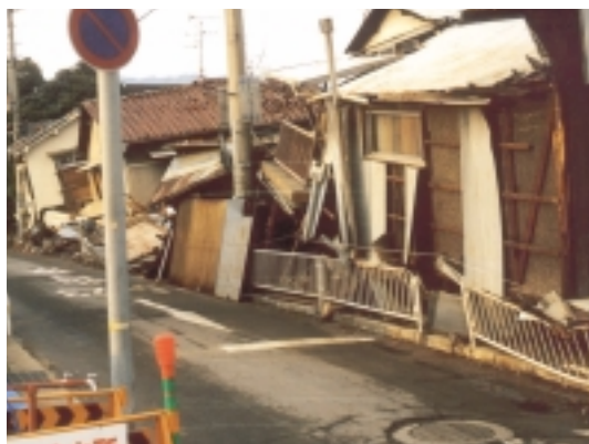
倒壊した家屋
